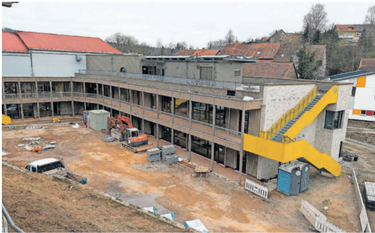
Der Innenhof ist derzeit noch eine Baustelle. Architektonisch prägen die hölzernen Laubengänge und zwei große gelbe Fluchttreppen das äußere Erscheinungsbild.
